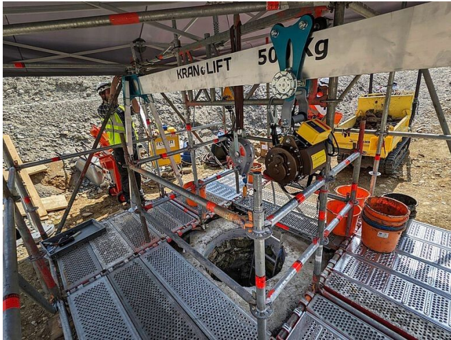
Für die Freilegung der Brunnenfüllung mussten ein Spezialgerüst und aufwendige Sicherungsgeräte mit Personen- und Lastenwinden aufgebaut werden. Foto: Landesamt für Denkmalpflege im Regierungspräsidium Stuttgart
