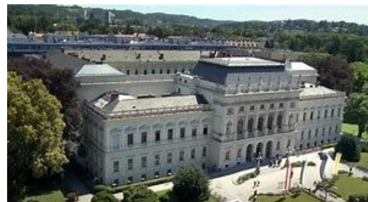
KF-Uni Graz, Hauptgebäude
