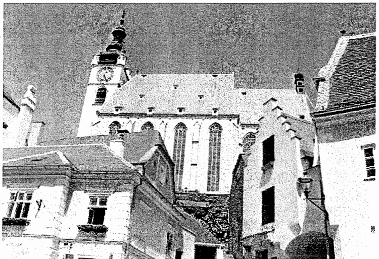
Krems: Blick zur Piaristenkirche
